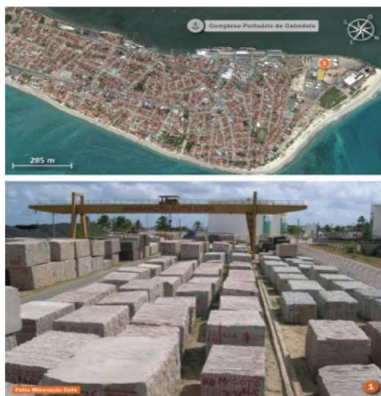
Figura 5: Pátio de armazenamento de granito. Fonte: Plano Mestre do Porto de Cabedelo - 2018
